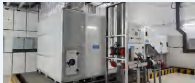
格力磁悬浮直膨式地铁车站智能通风空调系统
